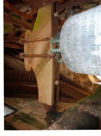
Le beffroi dans sa conception actuelle est bridé : cette disposition implique la transmission des contraintes dans les maçonneries lors de la mise en volée de la cloche et les poutres sur lesquelles elle est fixée sont en mauvais état et rongées par l'humidité = un nouveau beffroi
